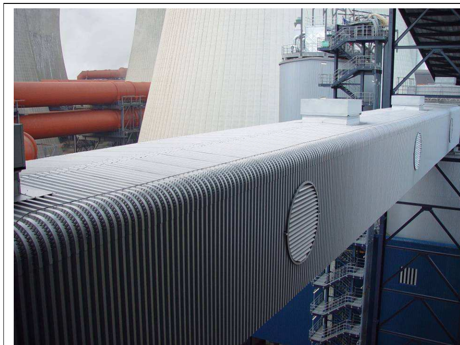
Kraftwerk Niederaußem - Kohlebandbrücken
